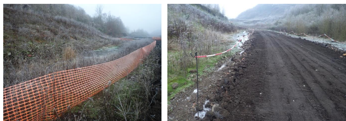
Figure 2 : Exemples de balisage perméable temporaire sur un chantier (Source : Atelier des Territoires)
