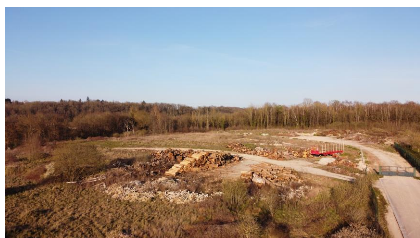
Photo 1 : Vue du site par drone (Source : TSE)
